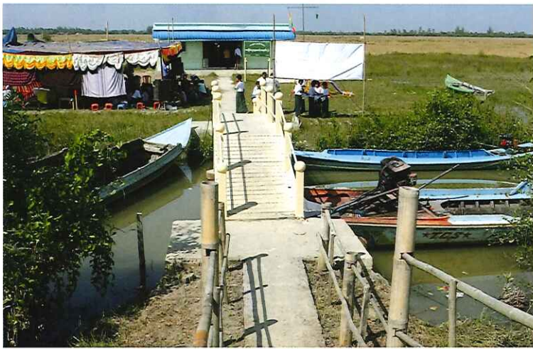
架け替えられた鉄筋コンクリート造りの「北村橋」。向こうが小学校
